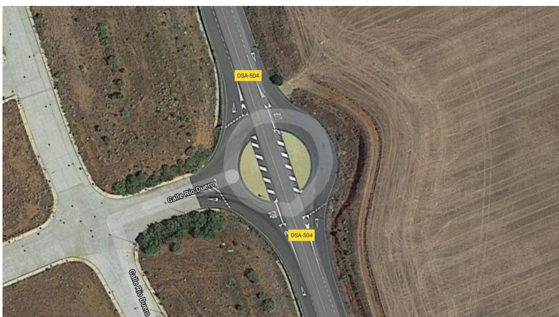
Detalle de la rotonda de acceso a ambos sectores
